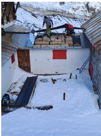
Sopra: la riparazione del tetto del corridoio che unisce i due rifugi In alto: Gianni e Laura lavorano al restauro dell'affresco dedicato a San Bernardo
