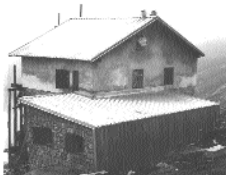
Sopra: I lavori di ampliamento nella fase avanzata
