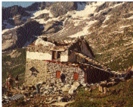
Un momento dei lavori di ampliamento (Archivio SEM)
